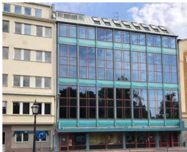
ÖLIS klubblokal, i Byggmästareföreningens Hus på Järntorgsgatan 3.
